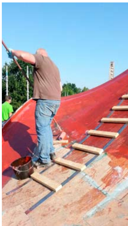
Met de rol is over de nieuwe onderconstructie in twee lagen een glasvezelversterkte polyester dakbedekking aangebracht.
