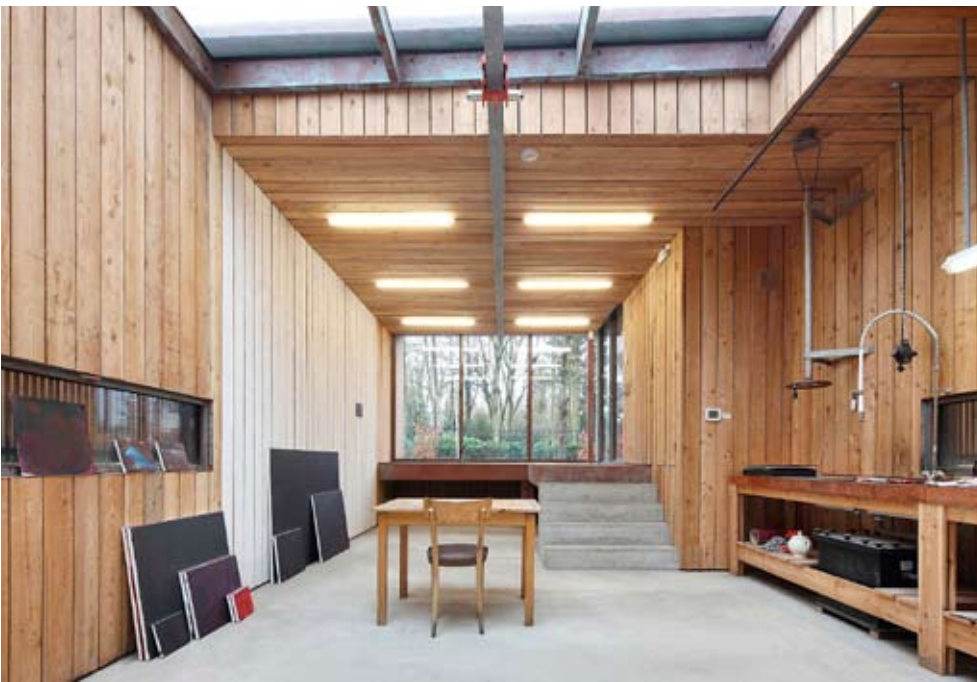
Het schuifdak dicht naar wens een groot daklicht af. De schuivende doosconstructie is volledig bespoten met een koperen afwerklaag.
