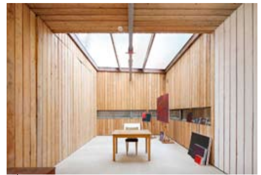
Het schuifdak dicht naar wens een groot daklicht af. De schuivende doosconstructie is volledig bespoten met een koperen afwerklaag.
