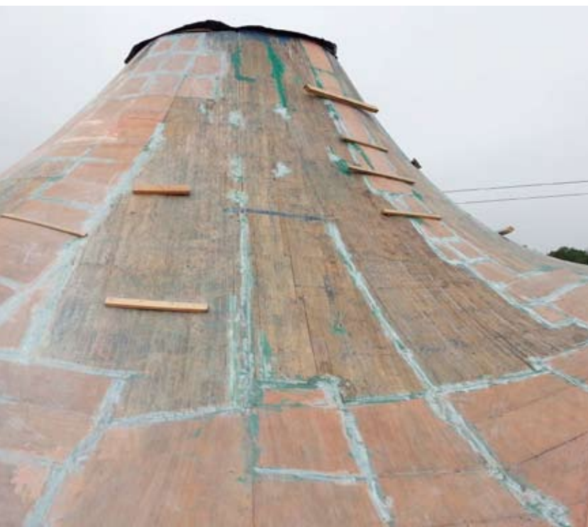
De aangetaste delen van de onderconstructie zijn vervangen en de naden zijn gedicht met plastische polyesterplamuur.
