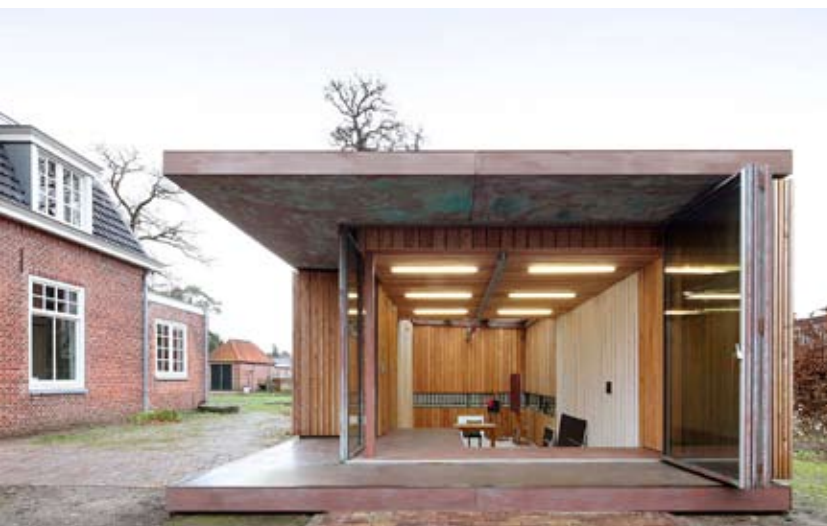
Ook de boeiboorden, de onderzijde van het dakoverstek, de vloer buiten en binnen en de stalen kozijnen zijn van een koperen spuitlaag voorzien.
